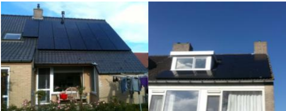
Figuur 6: Voorbeelden van daken met zg. "all black" panelen, in de uitvoering op basis van kristallijn silicium (links) of dunne-laag CIGS zonnecellen (rechts).
