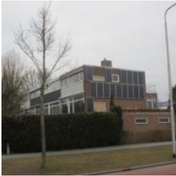
Figuur 3: Voorbeeld van zonnepanelen gemonteerd op een gevel (foto: Dirk van Baalen)
