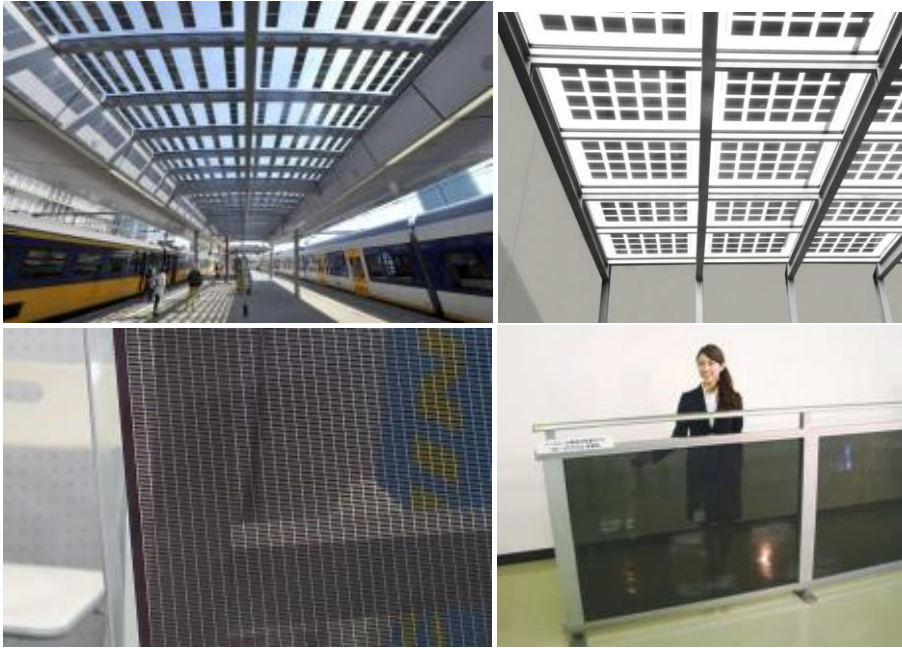
Figuur 11: Voorbeelden van doorzicht- of semitransparante zonnepanelen, op basis van kristallijn silicium (boven) of dunne-laag cellen (onder).
