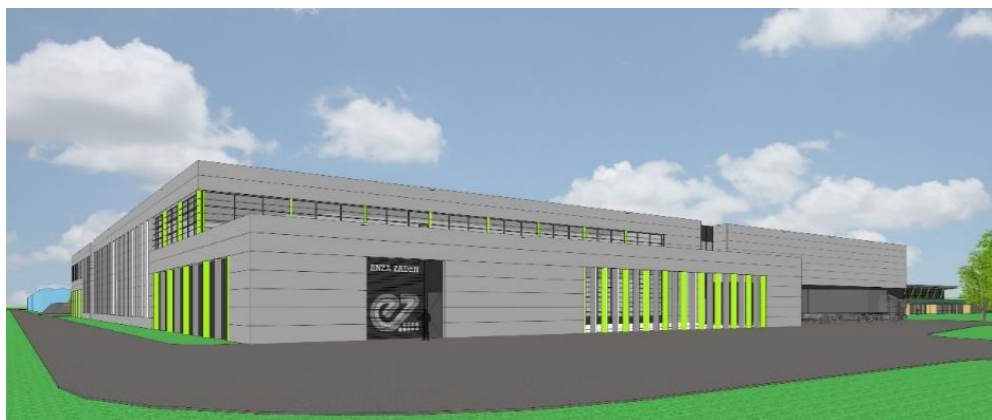
Expeditie aan de voorgevel, Zuid West zijde, Santsloot gebouw
