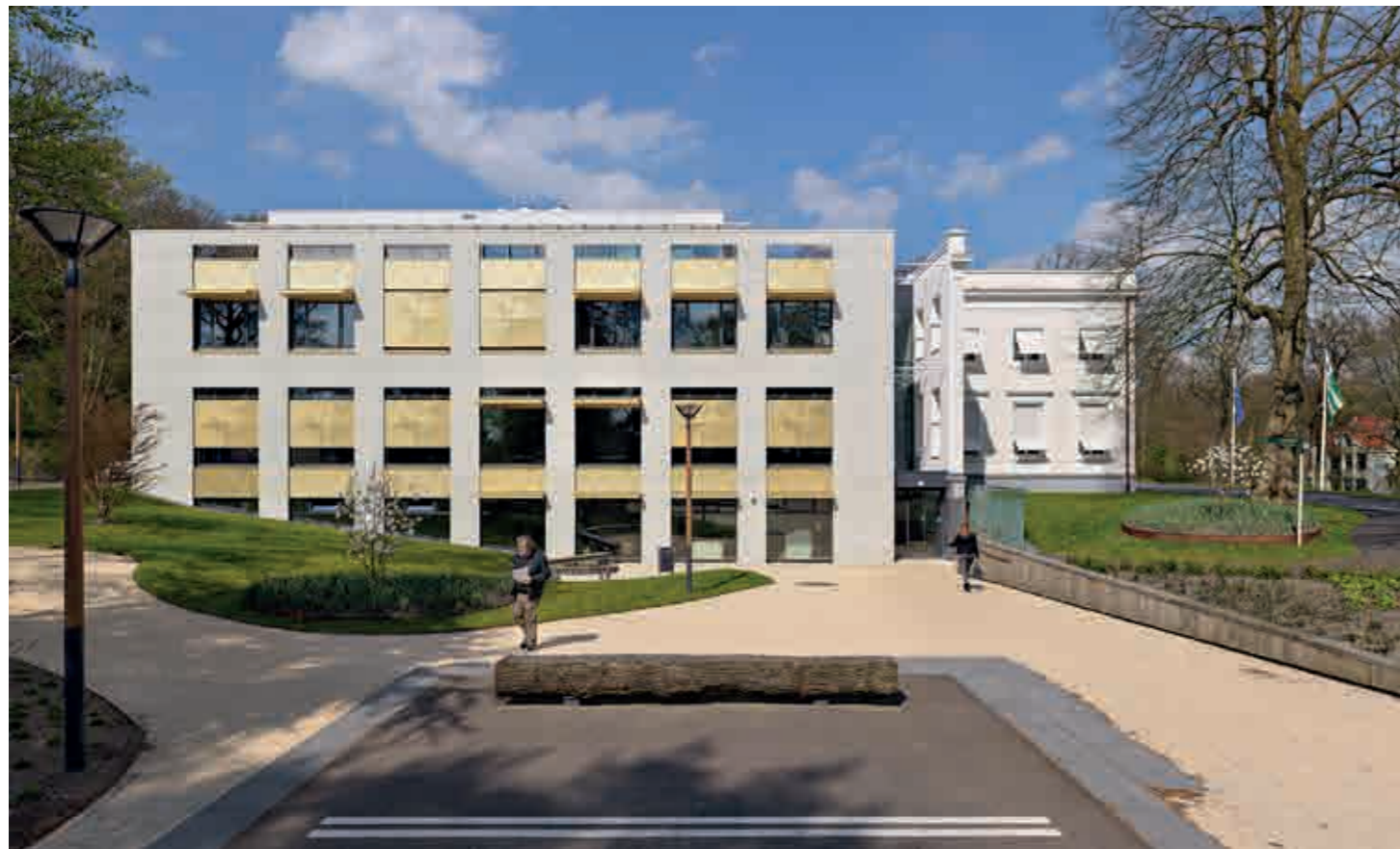
HET DUINLANDSCHAP WERD AFGEGRAVEN OM HET NIVEAU WAAR DE KELDER ZAT TE ONTSLUITEN
