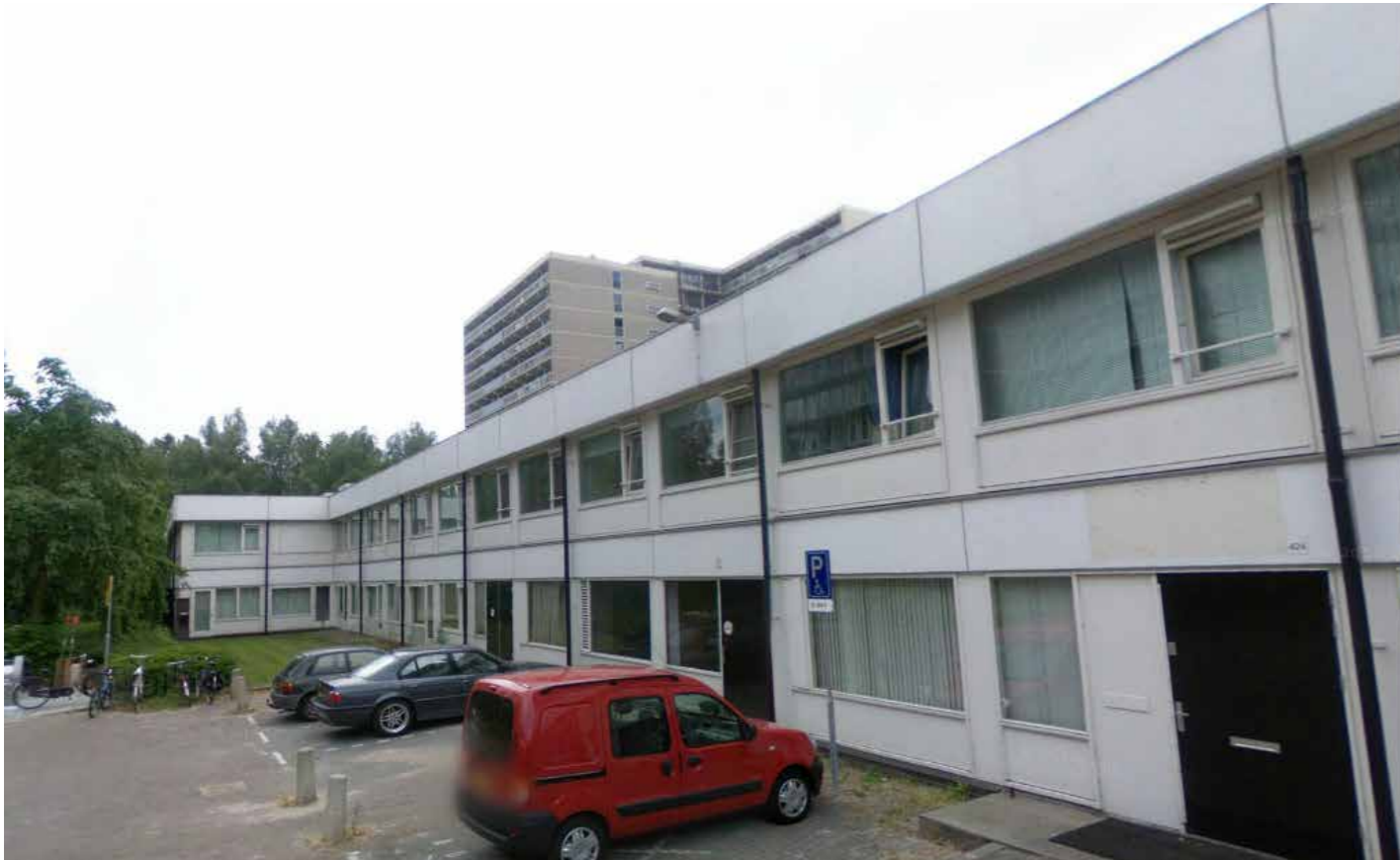
↑ OORSPRONKELIJKE SITUATIE ONTOEGANKELIJK
