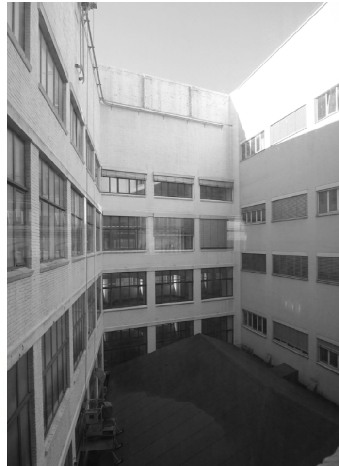
Oorspronkelijke situatie van het binnenhof
