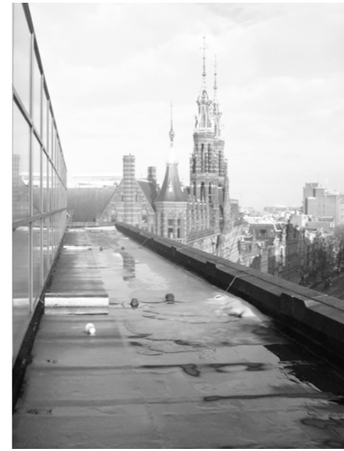
Oude situatie van het dak
