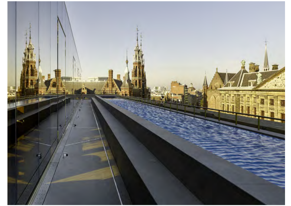
Het nieuwe zwembad op het dak
