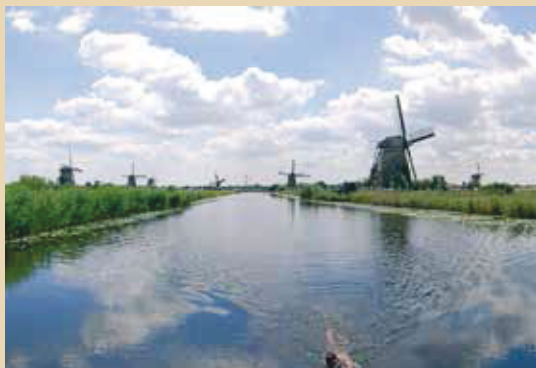
Met bewerkt beeld is duidelijk gemaakt dat windturbines bij Alblasserdam het zicht op de molens van Kinderdijk ernstig zouden hinderen (Impressie Land-ID)
