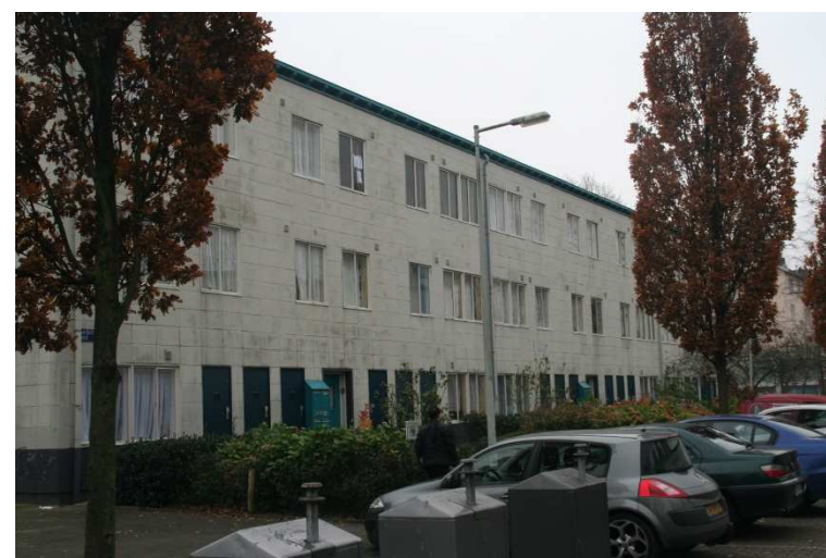
Drie blokken zijn geschilderd, bij deze blokken zijn wel nog de oorspronkelijke balkonhekken aanwezig.
