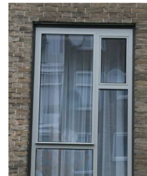
Het profiel dat door Eigen Haard eerder bij de Koningsvrouwen van Landlust is toegepast, wordt ook bij deze blokken gebruikt. Door de glasverlijming op de draaiende delen ontstaat er een mooie ranke profilering.
