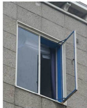
De oorspronkelijke stalen kozijnen worden vervangen door aluminium kozijnen.
