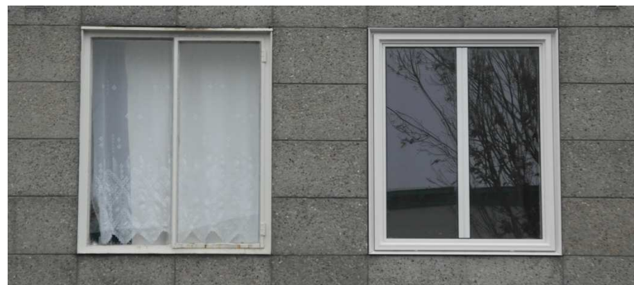
Links het originele kozijn in het proefstramien, rechts het eerste nieuwe aluminium kozijn. Het "stopverfprofiel" wordt ook op de middenstijl nog aangebracht. Daarmee krijgen de kozijnen meer plasticiteit.
