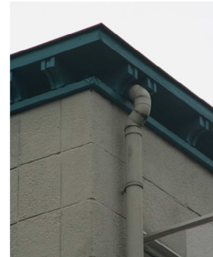
De detaillering van de dakrand is nog nagenoeg geheel intact, de hwa's zijn in het verleden aangepast.
