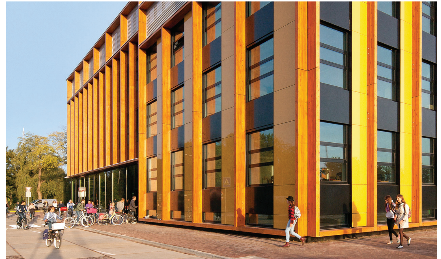
De Zuidzijde van het school gebouw biedt een semi-ondergrondse fietsenstalling als entree. De hoofdingang is aan de westzijde gesitueerd.
