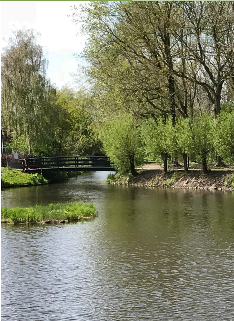
Nieuwe situatie: opgeknapte brug en broedeiland
