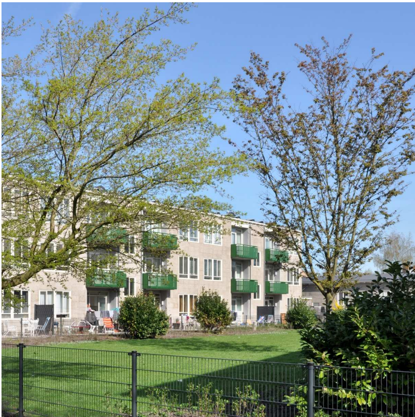
De balkons van de woningen aan de Burgemeester de Vlugtlaan zijn 60 centimeter dieper gemaakt. De kleur van de nieuwe hekwerken volgt uit het kleuren onderzoek.
