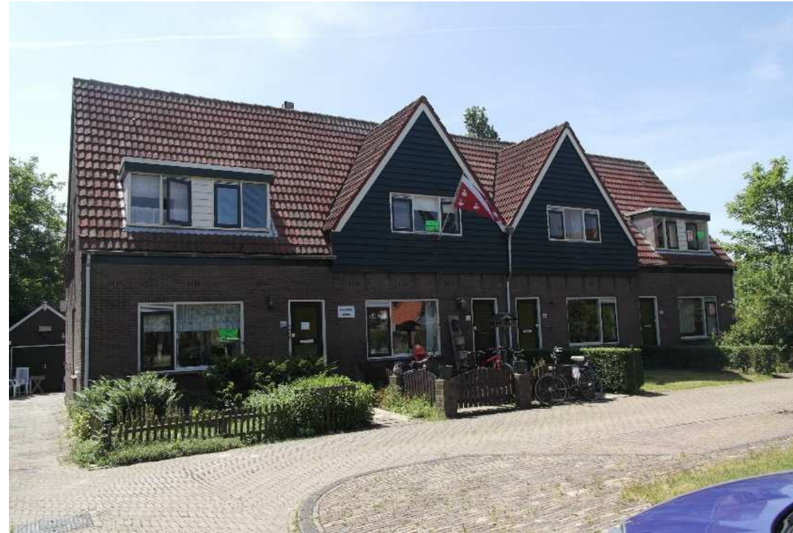
Gevelaanzicht voor renovatie
