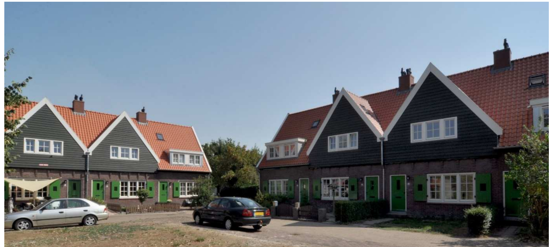
Gevelaanzicht na renovatie
