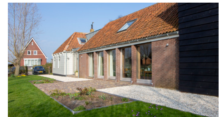
nieuwe toestand : tussenlid insnoeren en stal met muurdammen
