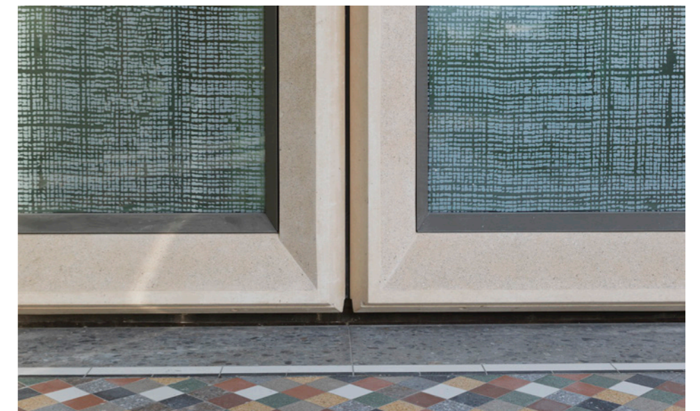
Detail van de gevelpanelen en print op de ramen
