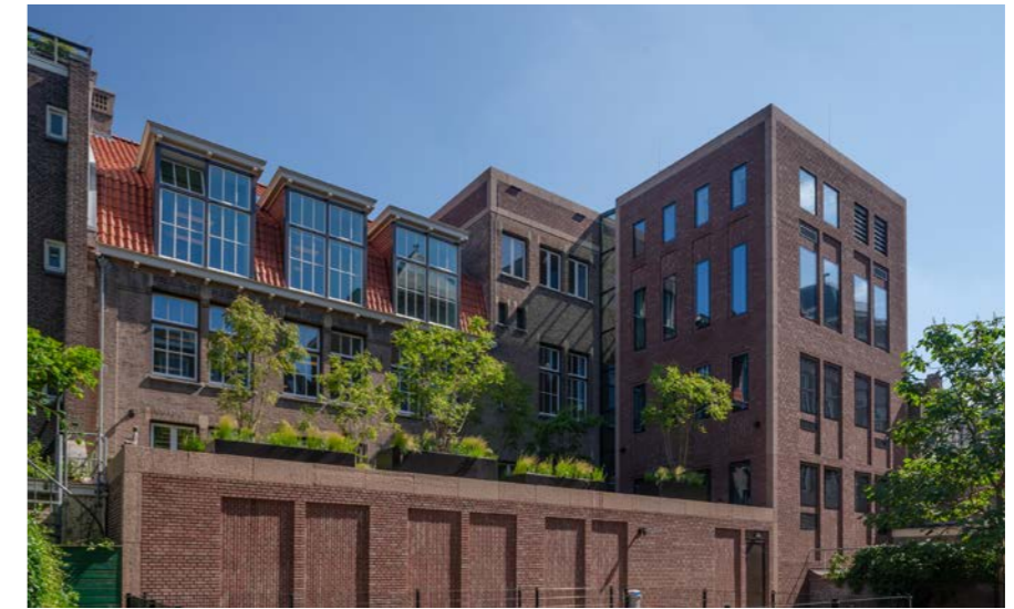
Achtergevel na restauratie
