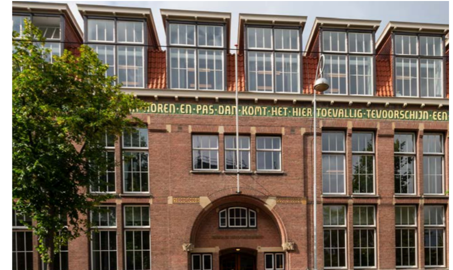
Voorgevel na restauratie
