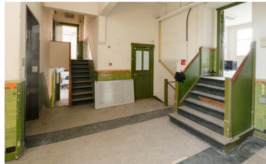
Overloop vóór restauratie, rechts trap naar directeurkamer
