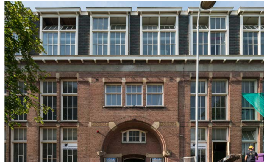
Voorgevel vóór restauratie
