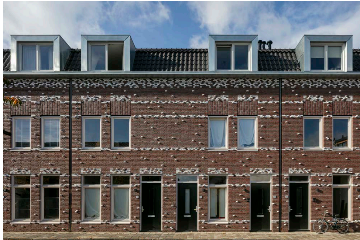
Gevelaanzicht vanaf Palmstraat.
