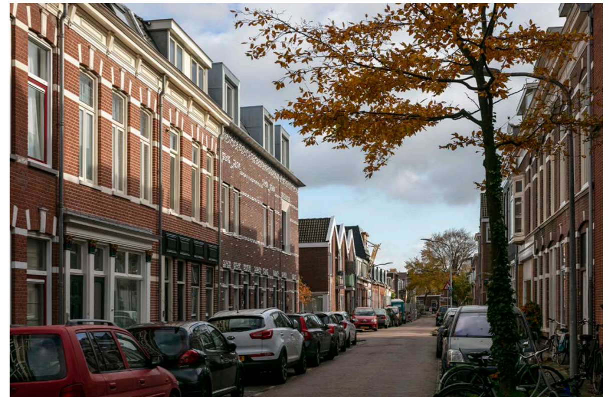
Gevel overloop aan de Barendsestraat.
