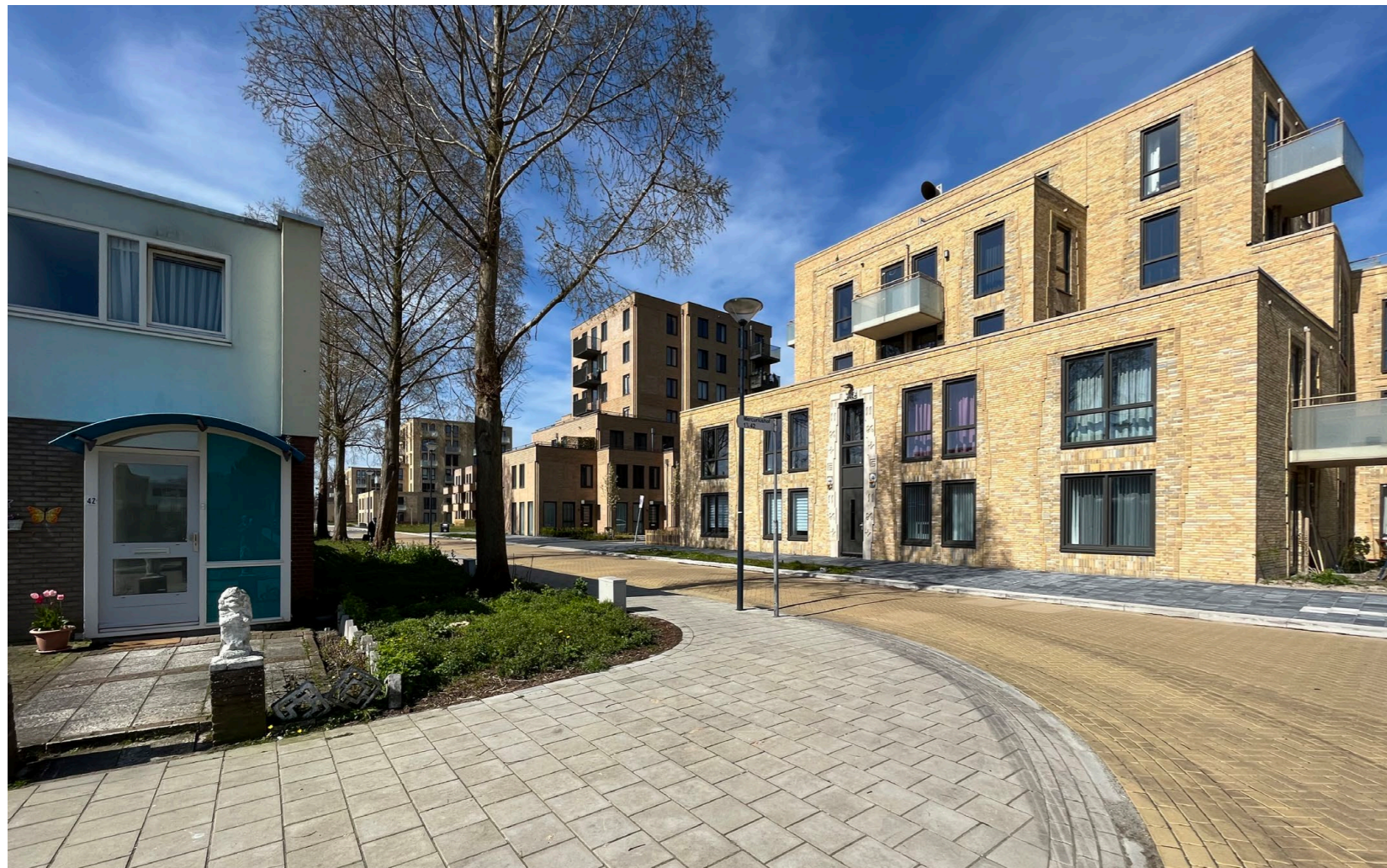
een gelede massaopbouw met set-backs (tot 7 lagen), die nergens te massaal aanvoelt en harmonisch aansluit op de bestaande wijk.
