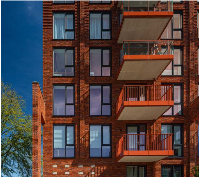
Detail metselwerk en balkons aan westgevel
