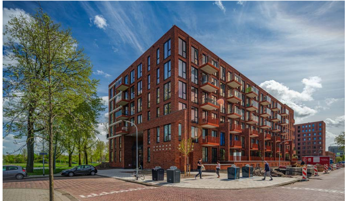
Zicht op west- en noordgevel vanaf Hannie Schaftstraat
