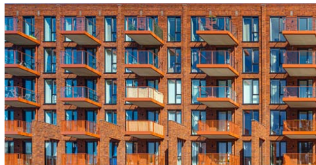
Westgevel met metselwerkdetails en balkons
