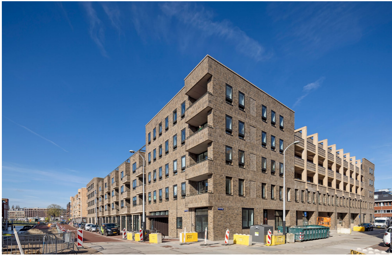
Hoek oost met op de noordoost-gevel galerijen aan de straat die worden geaccentueerd met een betonnen frame.
