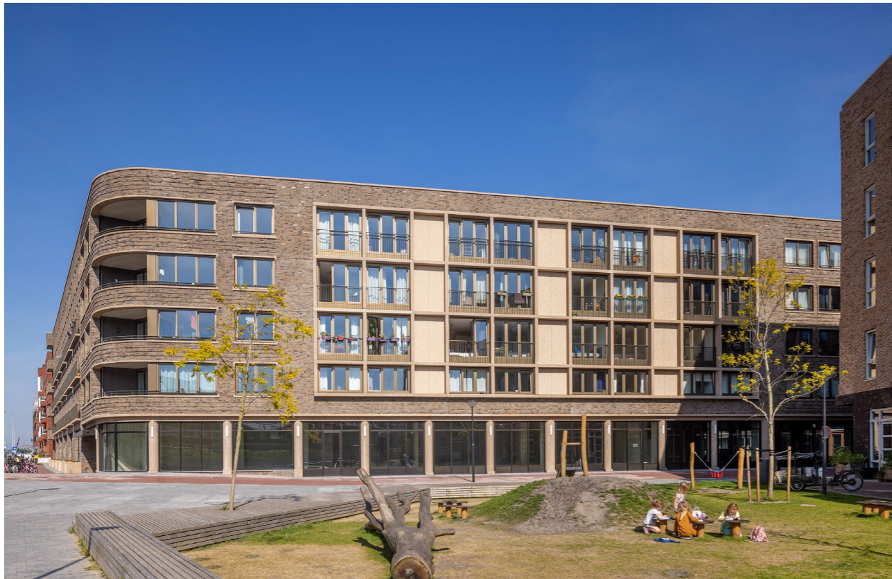
Hoek noordwest. De gevel is opgebouwd uit verschillende elementen waardoor er diversiteit in ritmiek en schaal ontstaat.
