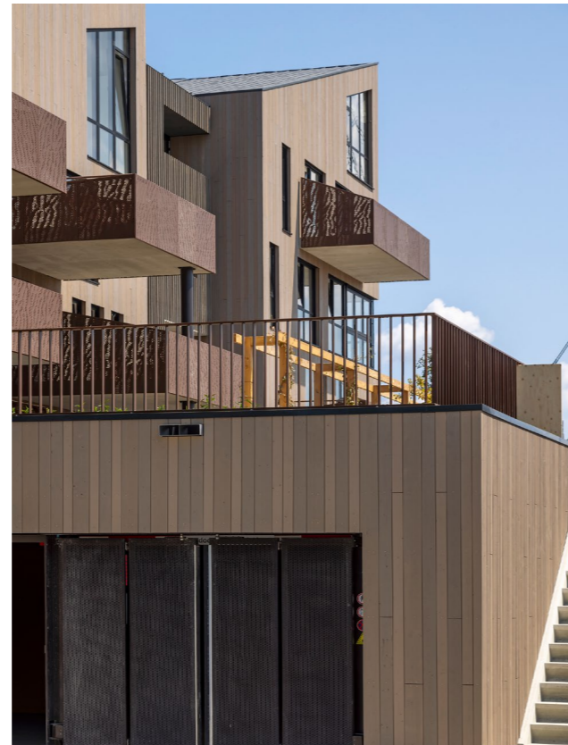
Links: fragment van de zuidgevel, de vluchtbalkons van de veiligheidstrappenhuizen zijn met open latten afgewerkt. Op de begane grond is dit nog niet af. Rechts: inrit van de parkeergarage op maaiveld met rechts een van de trappen naar de daktuin.
