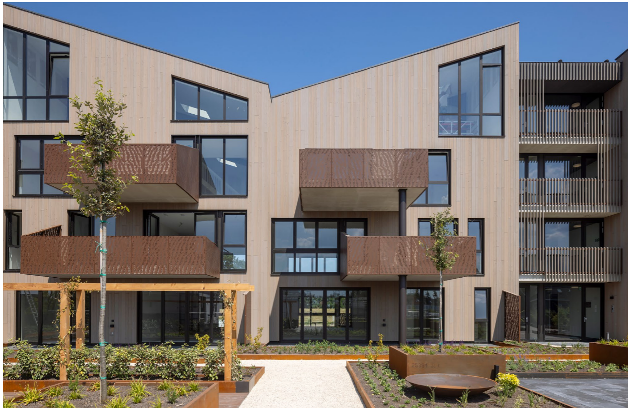
Fragment van de zuidgevel aan de opgetilde daktuin op de parkeergarage
