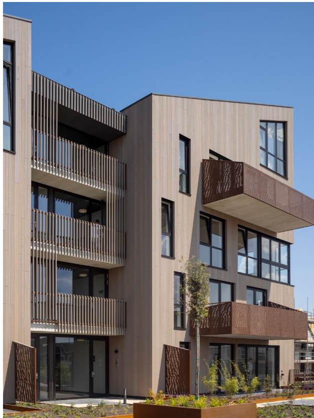
Links: fragment van de zuidgevel, de vluchtbalkons van de veiligheidstrappenhuizen zijn met open latten afgewerkt. Op de begane grond is dit nog niet af. Rechts: inrit van de parkeergarage op maaiveld met rechts een van de trappen naar de daktuin.
