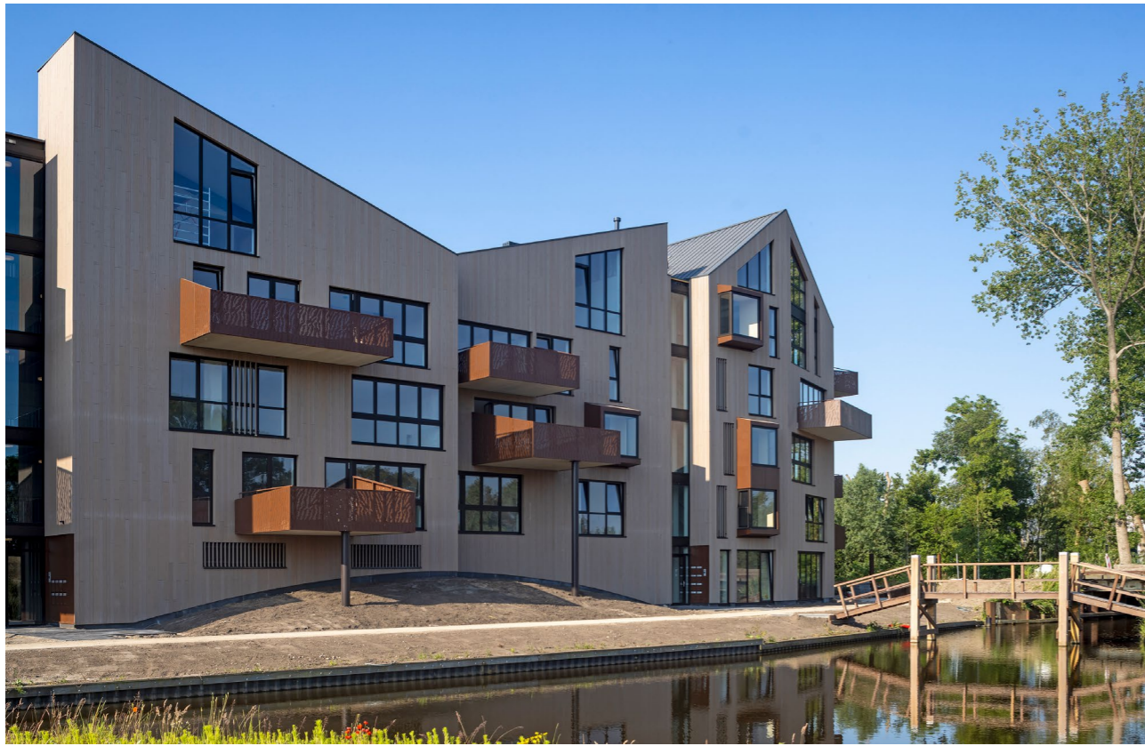
Noordgevel met verspringende bouwmassa van de bouwdelen en schuine daken.
