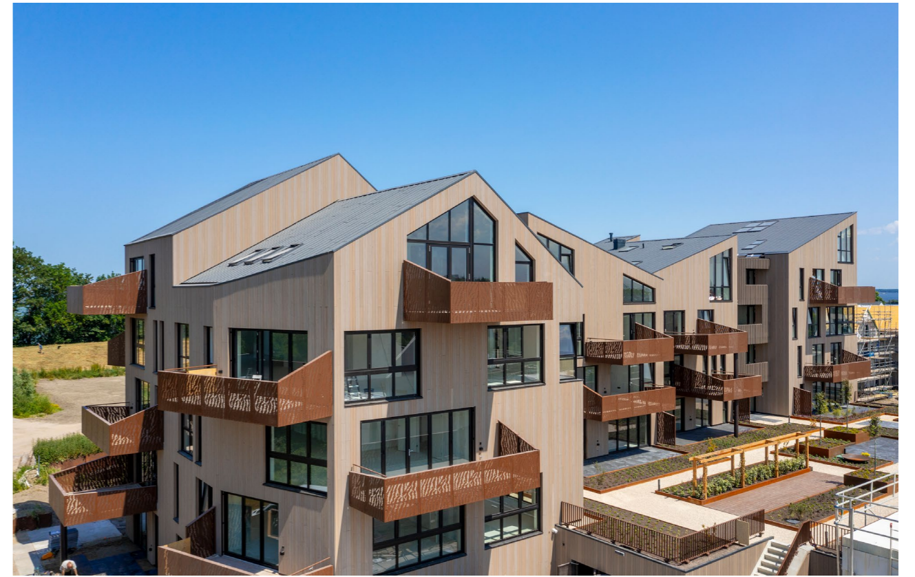
Westgevel en zuidgevel met verspringende puinen en balkons. De daken zijn van antraciet gecoate geprofileerde staalplaat
