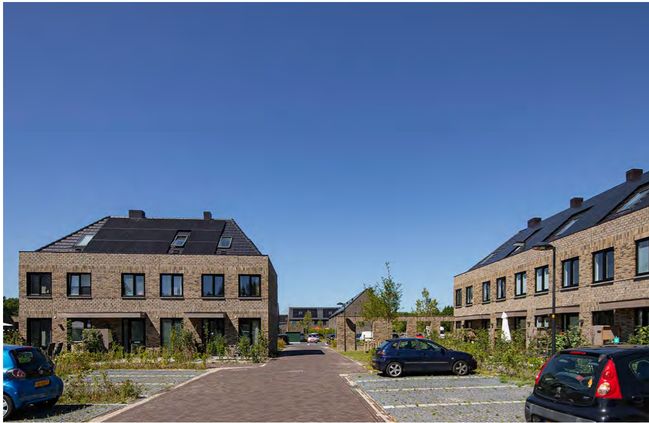
Parkeerplaatsen Poortgebouw Noord
