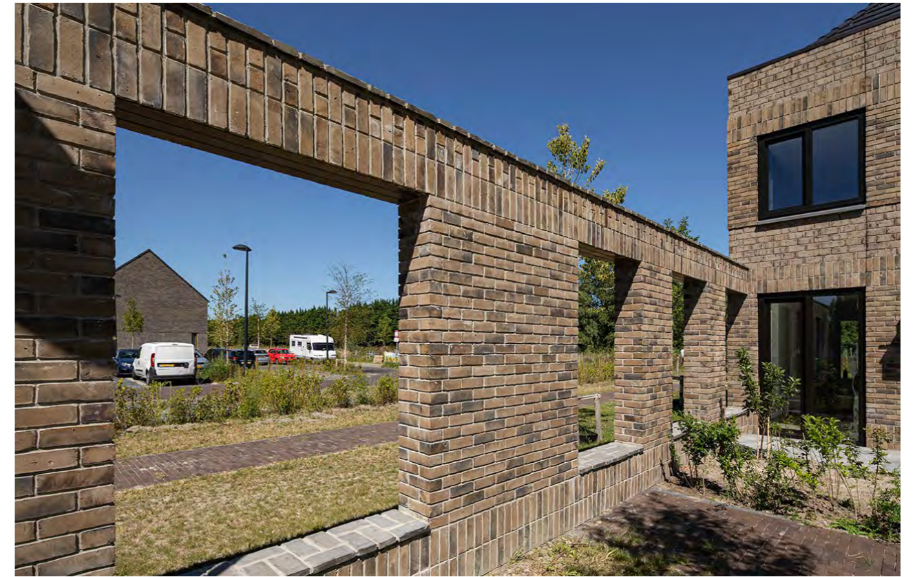
Detail Poortgebouw muur
