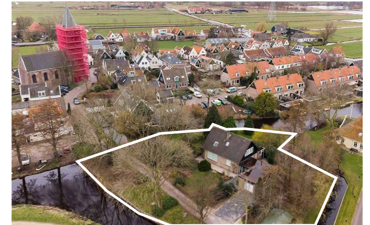
locatie bestaande toestand
