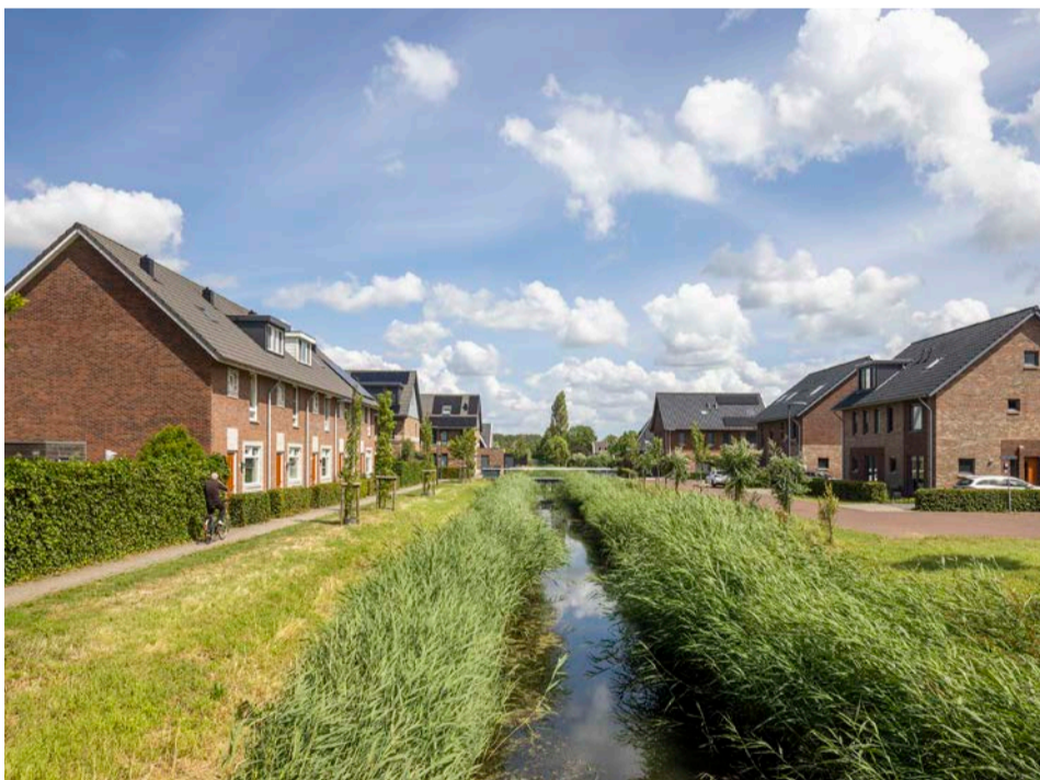
De zorgvuldig geplaatste bomen en aangelegde sloten zorgen voor een landelijk karakter
