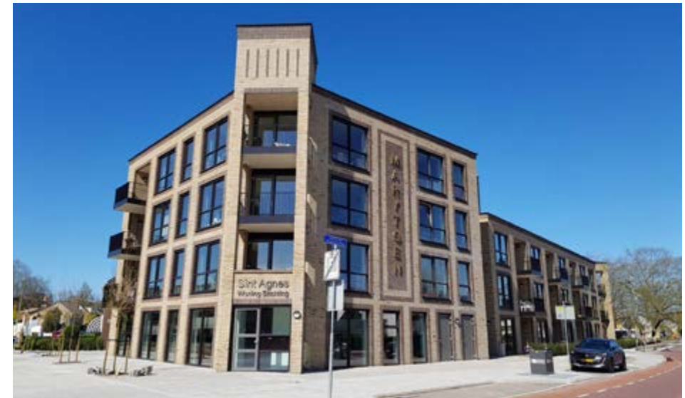
Studio-gebouw A - Amsterdam
