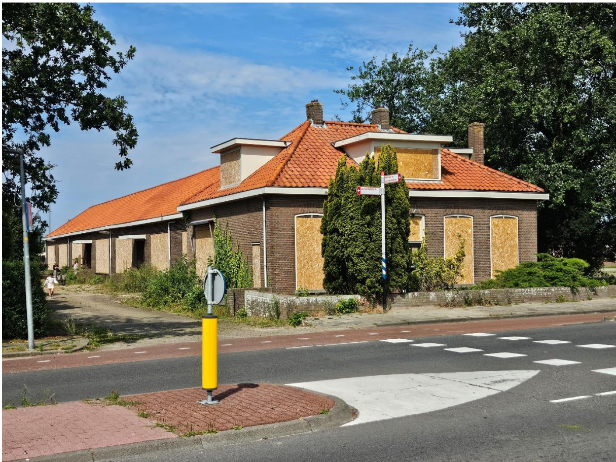
Afbeelding 1: School nr. 1, Langevliet 58-60, Julianadorp. Tijdens de bezichtiging stond het gebouw leeg en waren de gevelopeningen van het gebouw dichtgezet.
