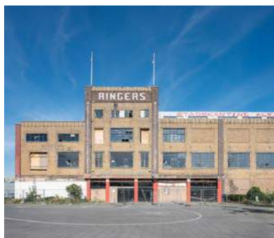
De Ringersfabriek in Alkmaar. Eén van de voorbeeldprojecten herbestemming die het Steunpunt publiceerde.
