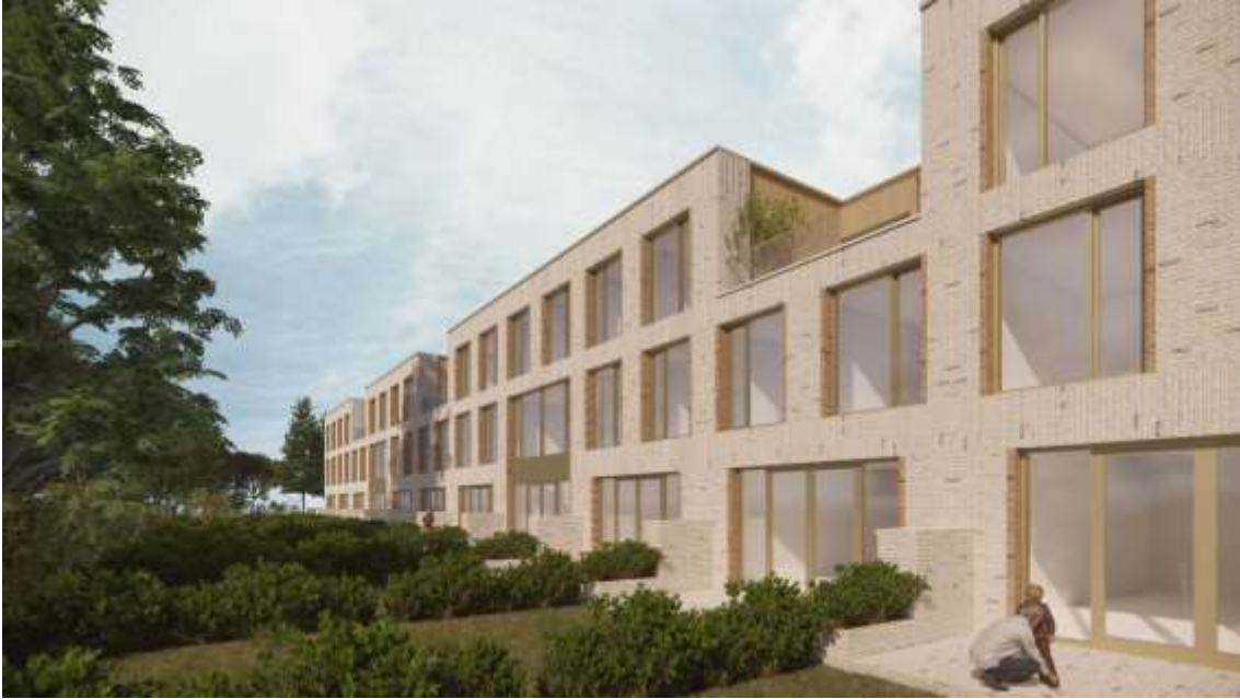
De mee-ontworpen buitenruimte. Het beheer van de erfafscheidingen is in de VvE geregeld. De neggen van de raampartijen zijn een referentie naar het gesloopte klooster. Beeld: Thunnissen.
